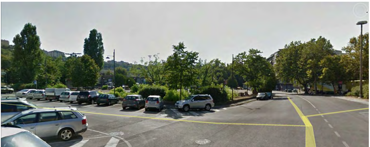
Fig.7 - La situazione attuale di p.le De Gasperi (a destra il sito ex Fiera)
